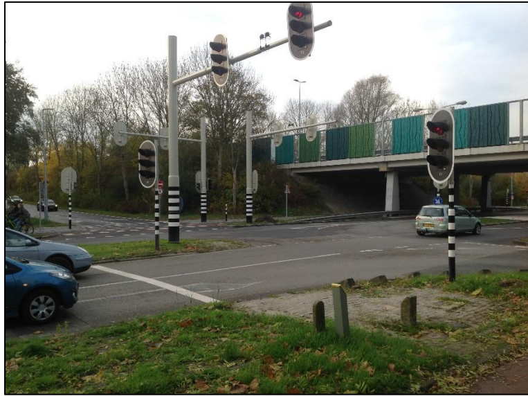
Figuur 1 Entree Zernikecomplex = viaduct
