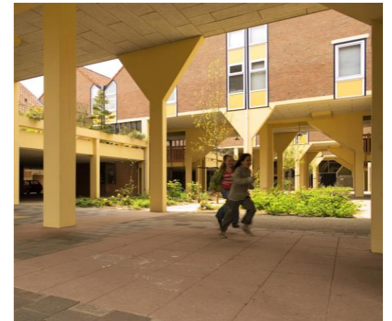
Afbeelding 20: onderzijde van de Kasbah.
