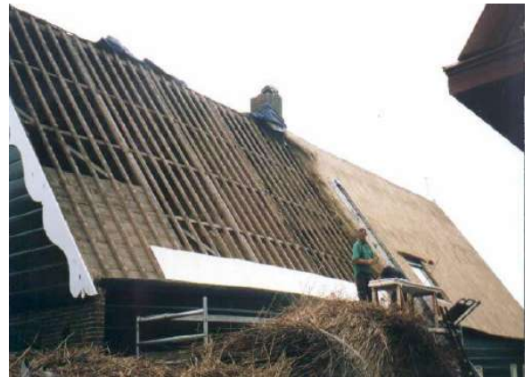
FIGUUR 16 - VOORBEELD DAKOPBOUW RIETEN DAK
