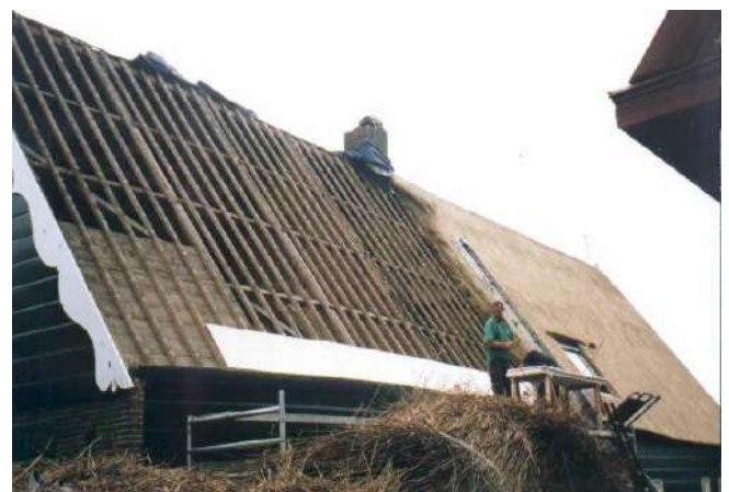
FIGUUR 30 - RIETEN DAK ISOLATIE
