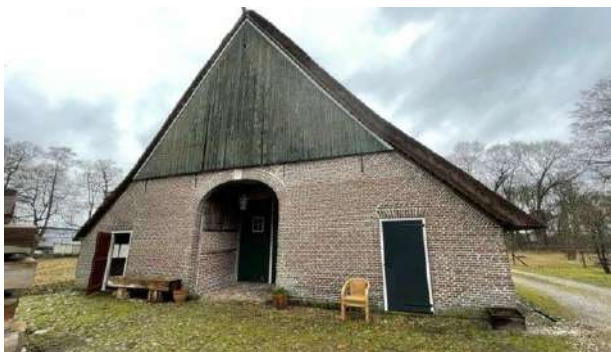
FIGUUR 39 – HUIDIGE VOORGEVEL ENGELENWEIJ
