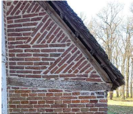
FIGUUR 14 METSELWERK HALFSTEESENVERBAND
